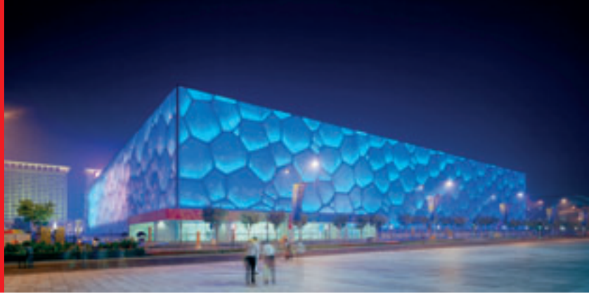
Fassadenkonstruktion aus Kunststoffen der Firma Vector Foiltec GmbH
