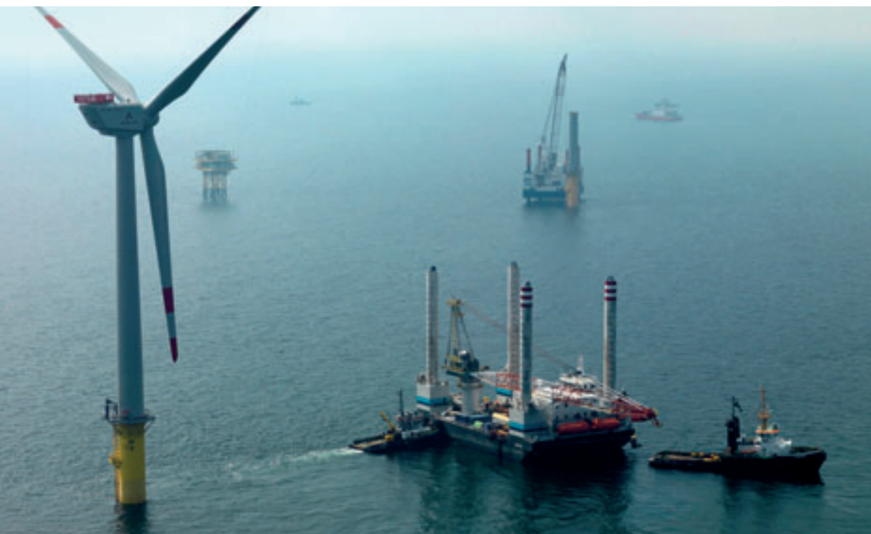
Installationsplattform für Windenergieanlagen in der Nordsee
